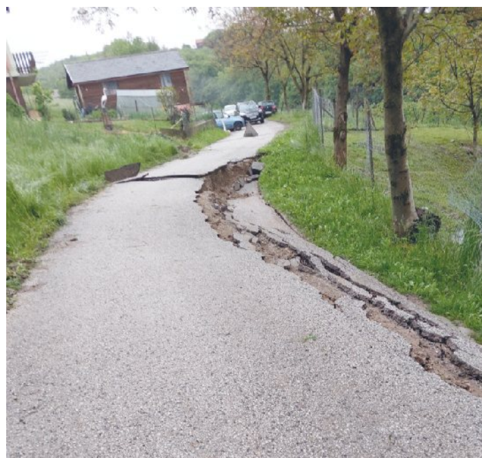
Zemljinski plaz zasul dostop do stanovanjskih objektov / Foto: arhiv občine
