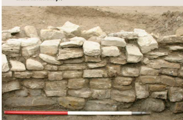
26 Ostaline grajenega obrežja nekdanje obale v izkopnem polju 2, detajl zidne konstrukcije.
