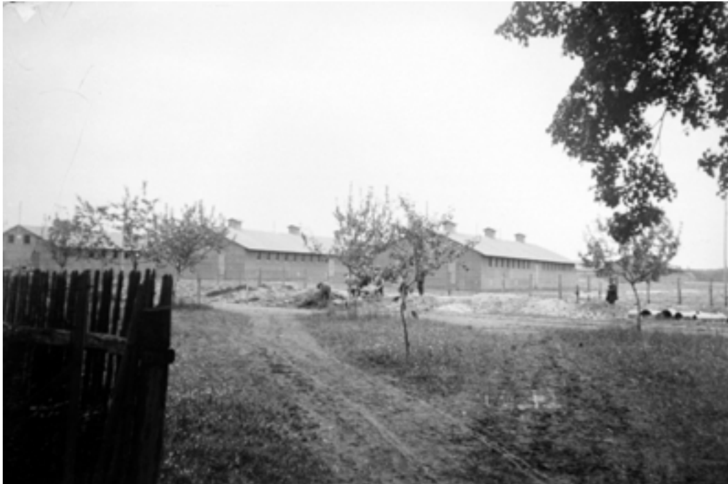
Pogled na barake vojne bolnišnice. 1915. Fotografija. Fotodokumentacija PMPO.
