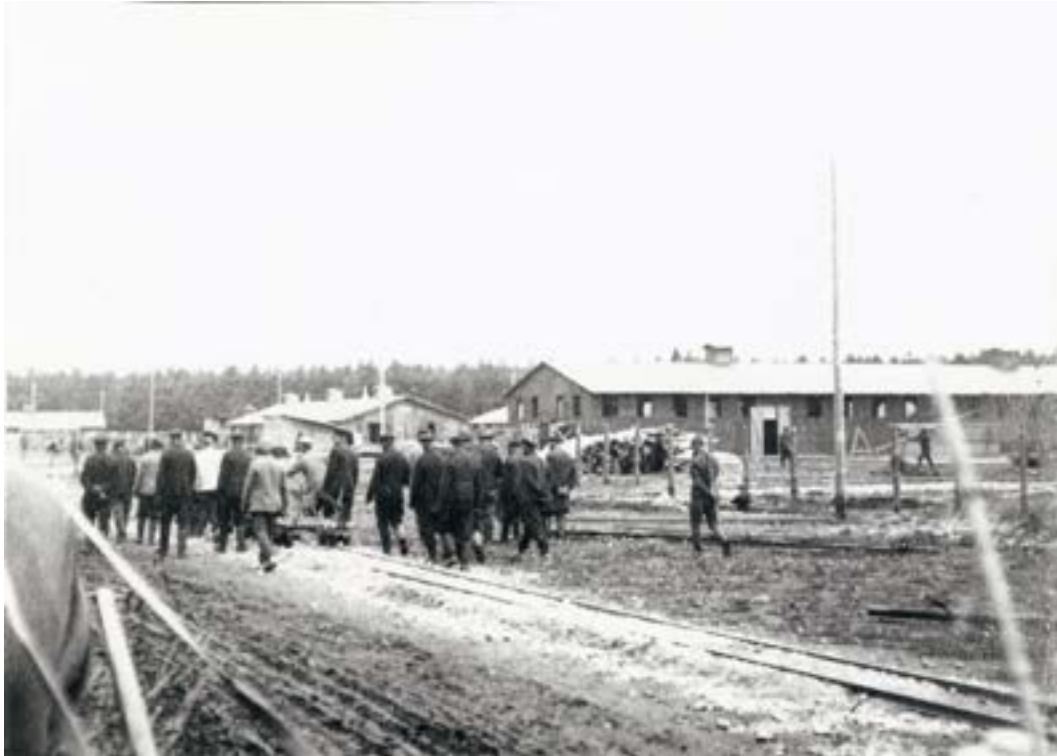
Gradnja vojaških oziroma bolnišničnih barak. 1915. Fotografija. Fotodokumentacija PMPO.
