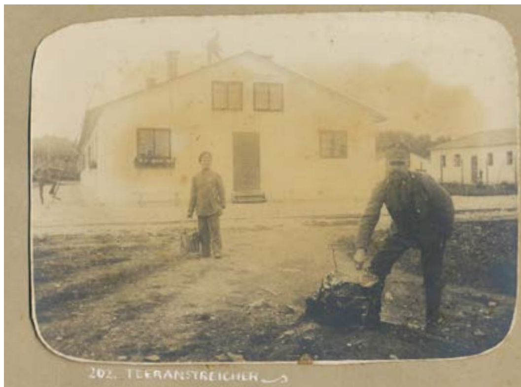
Priprava katrana za zaščito barake. Fotografija. Album rezervne bolnišnice Lukavac, 1916. PMPO.
