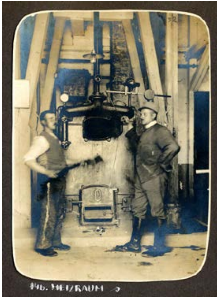
Kotlovnica. Fotografija. Album rezervne bolnišnice Lukavac, 1916. PMPO. Heizungsraum. Fotografie. Album Reservespital Lukavac, 1916. PMPO. Boiler room. Photo. Album reserve hospital Lukavac, 1916. PMPO.
