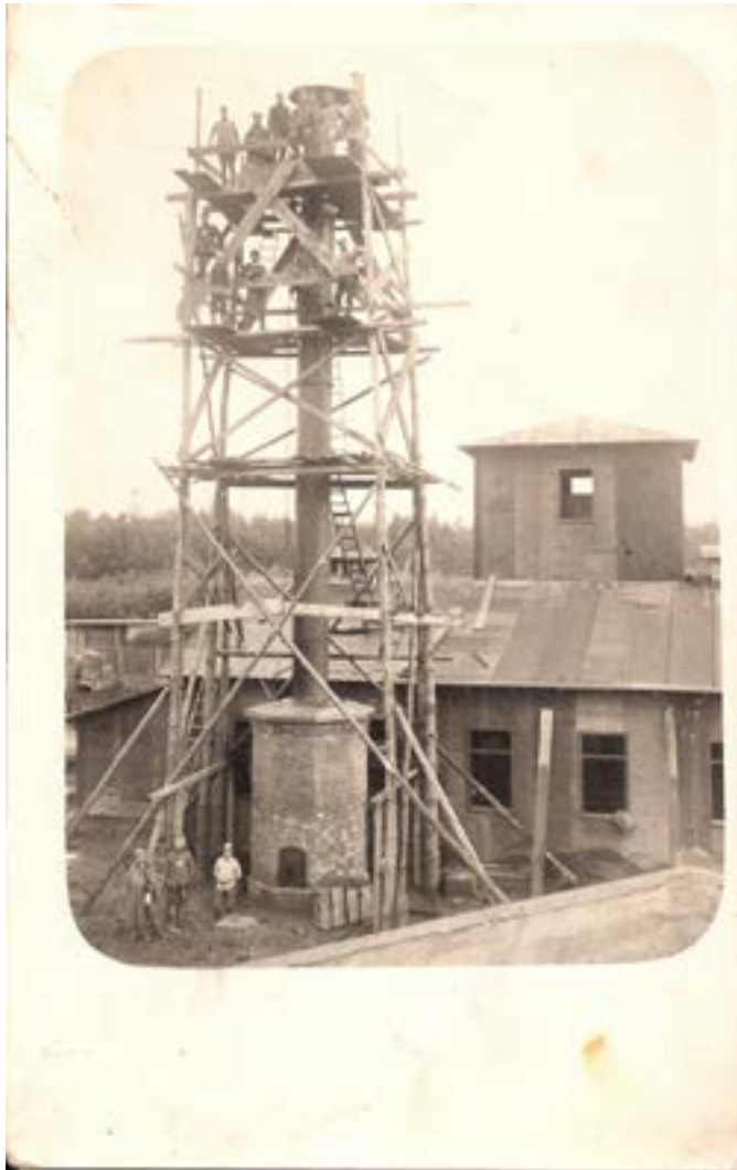
Gradnja dimnika za potrebe parne elektrarne. 1915-1916. Fotorazglednica. Zasebna zbirka Aleksandra Kumra.
