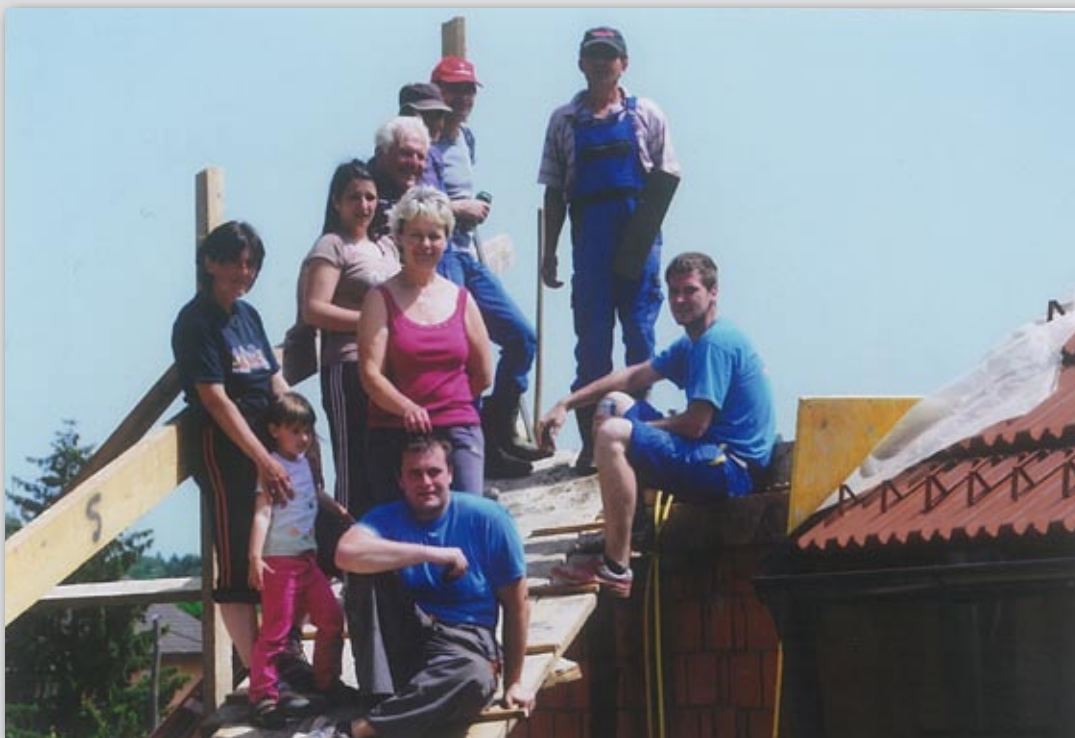
Delovna skupina pri betoniranju plošče
