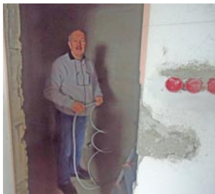
Polaganje kablov za elektrifikacijo
