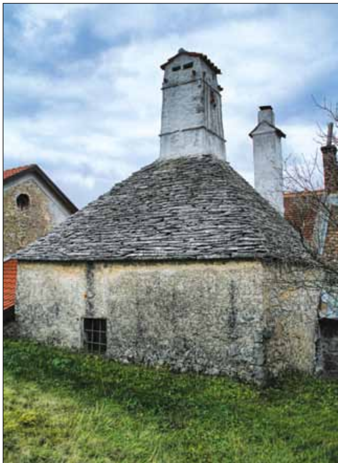
Spahnjenca na Šobčevi domačiji – na zunanji strani hiše prizidan prostor z odprtim ognjiščem in dimnikom
