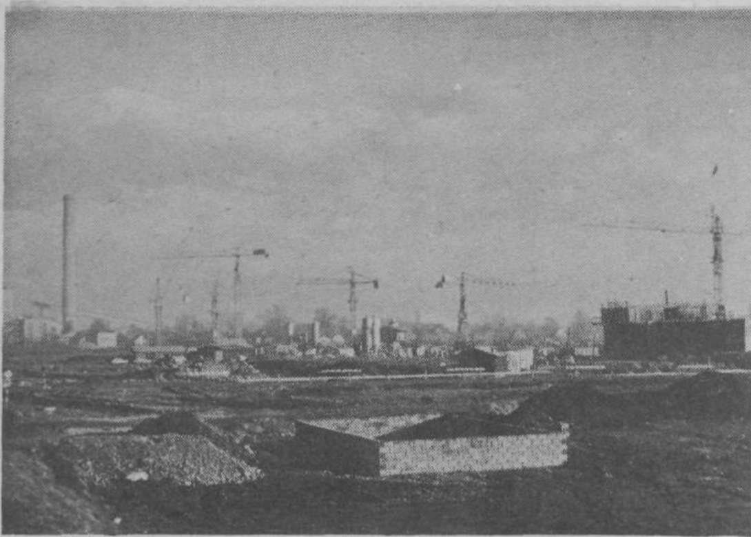
Na gradbišču v Štepanjskem naselju je ves dan živahno. Množica žerjavov in druge sodobne gradbene tehnike ter preizkušena tehnologija tunelskih opazov zagotavljajo hitro gradnjo. Tudi letošnja izredno blaga zima je gradbincem naklonjena
