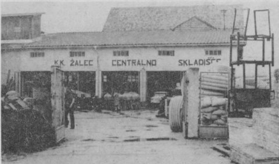
Poleg notranje trgovine TOZD Veleprodaja-centralno skladišče, je v Vrbju tudi Hmezdova tozd Transport ter Ingradova betonarna.
