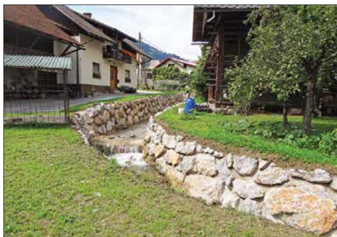
Na Bočnici je zaključena sanacija potoka v dolžini 380 metrov.
