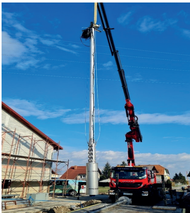
Inštalacija potopne črpalke (Foto: B. Naglič)
