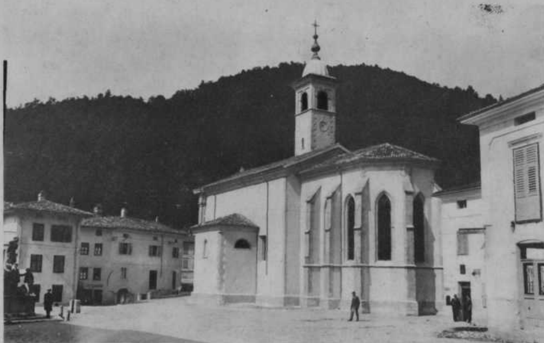
Župna cerkev v Kanalu na Goriškem, obnovljena od italijanske vlade, katere edina svella stran je, da marljivo obnavlja po vojni porušene stavbe.
