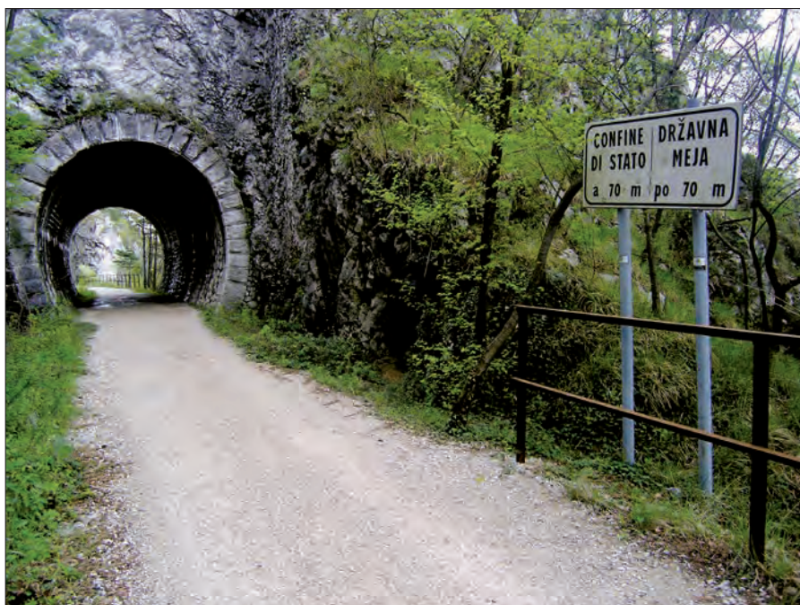
Predor na nekdanji železniški progi Trst–Kozina. Trasa je spremenjena v kolesarsko in sprehajalno pot. Foto: Primož Pipan.
