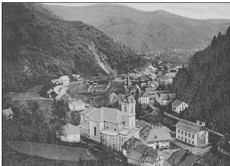
Železniki okoli leta 1910. Demšarjeva ("Dagarinova") hiša skrajno desno (last Angelike Hribar).
