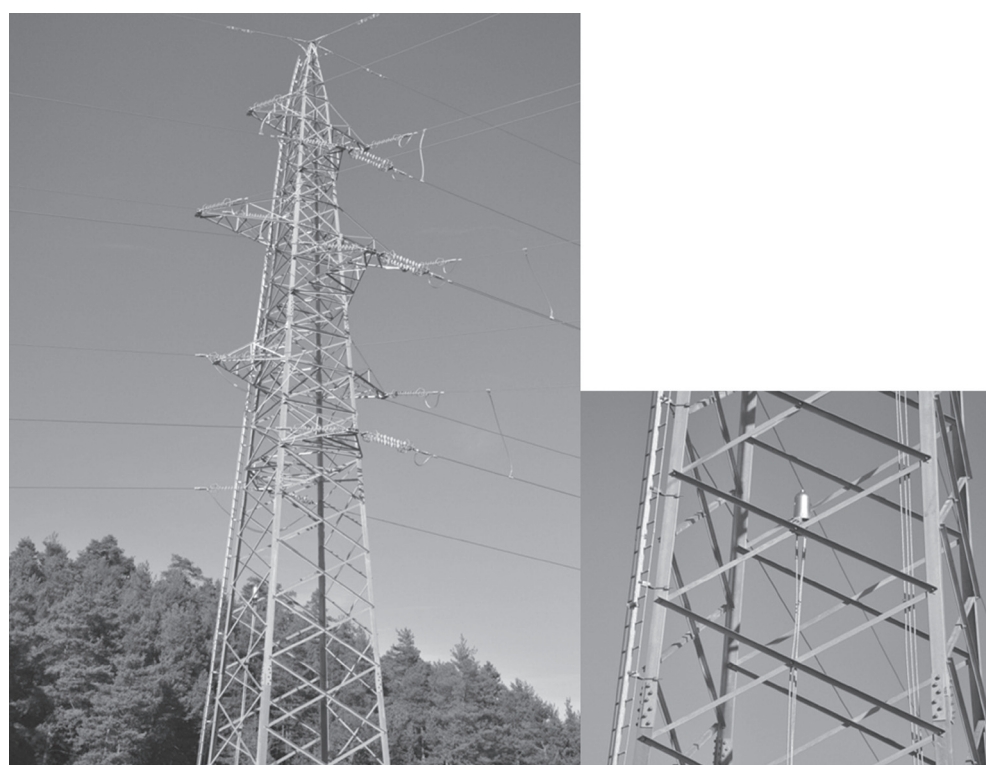
Slika 5: Zatezni steber SM80 – razcep proti Litiji
