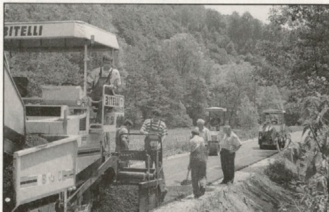
Asfaltiranje lokalne ceste tik ob mejnem prehodu Gruškovje
