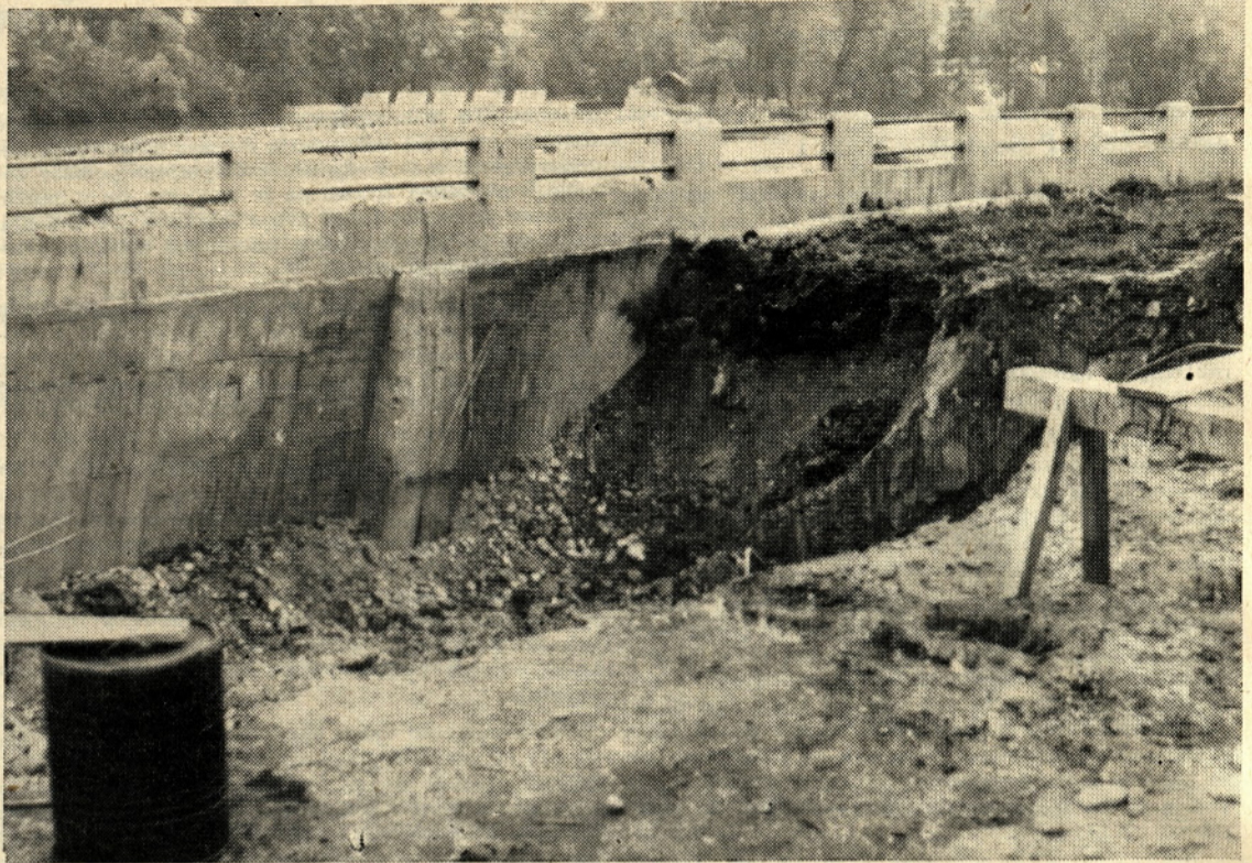
Cisterne za vnetljive tekočine so sedaj že vgrajene, in sicer v tej jami.
