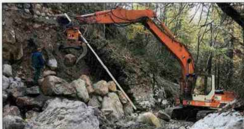
Občina je poskrbela, da so popravili oporni zid pod cesto v Dolino.
