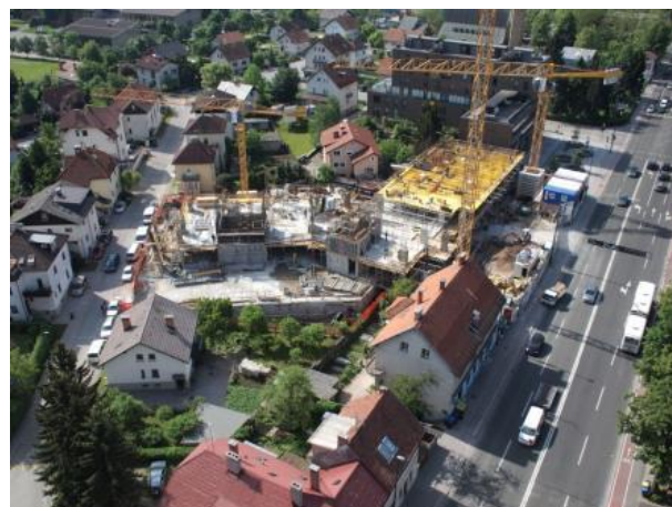
(b) Posnetek gradbišča; perspektiva 1a (b) Aerial photo; perspective 1a
