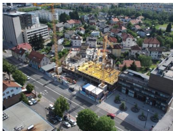
(d) Posnetek gradbišča; perspektiva 2 (d) Aerial photo; perspective 2
