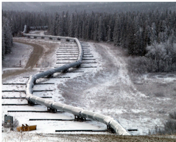
Slika 10: Transaljaški naftovod na območju preloma Denali za kompenzacijo premikov ob potresnem prelomnem pretrgu poteka v cik-cak obliki na teflonskih nosilcih. (vir: Wikipedia)
