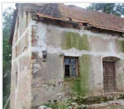
Stanje pred izvajanjem del
