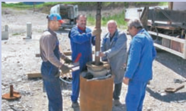
Z leve sin Marko in oče Pavel Lampič s pomočnikoma pri instaliranju črpalke
