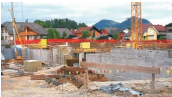
Na gradbišču so v preteklem tednu zaključevali z izdelavo kletnih sten.
