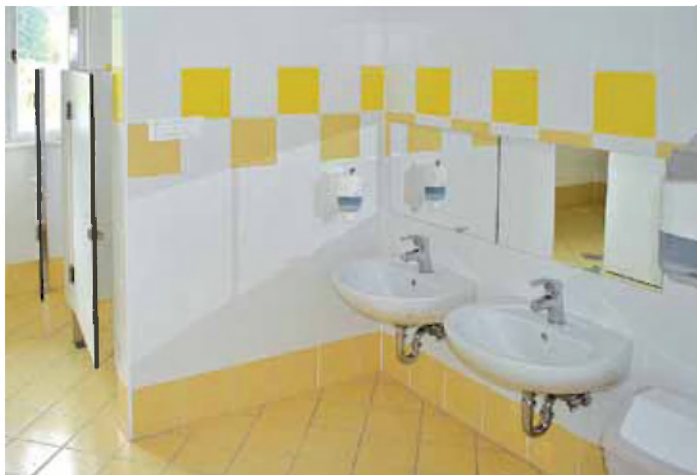
Pogled v prenovljen toaletni prostor
