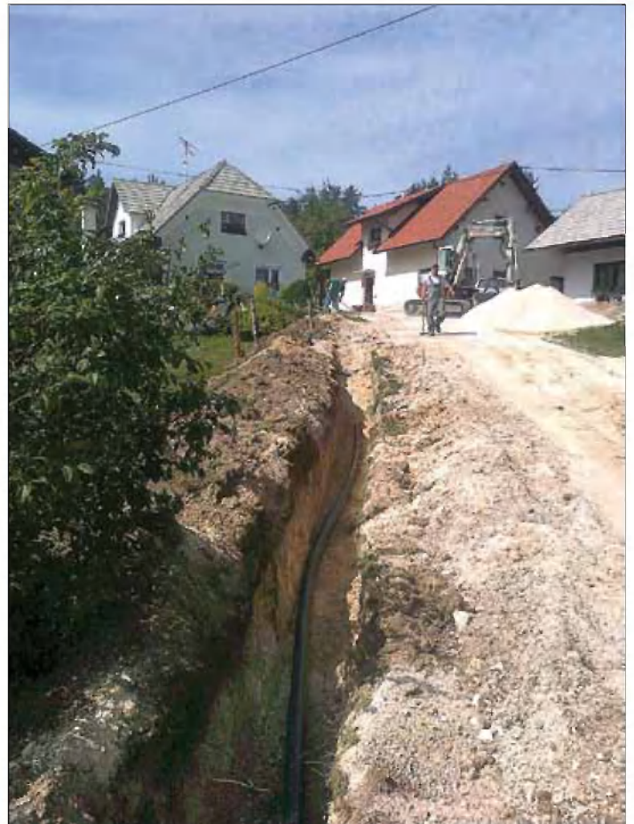
Gradnja vodovoda Karlovica–Podkogelj–Krkovo
