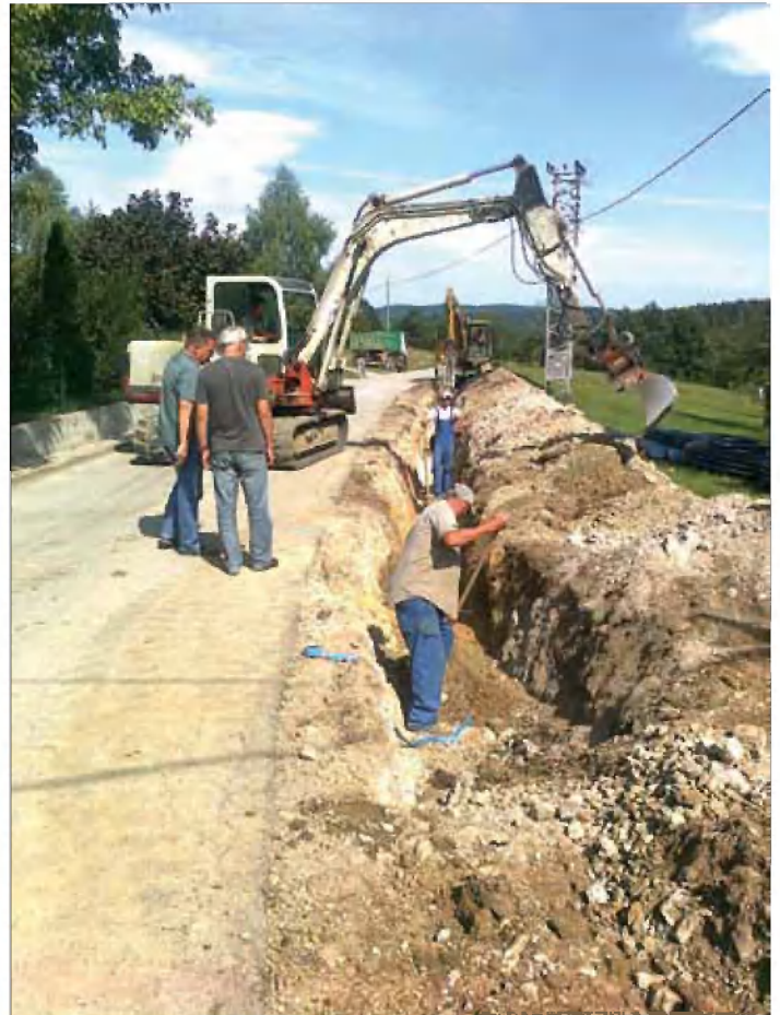
Gradnja vodovoda Ulaka–Podulaka
