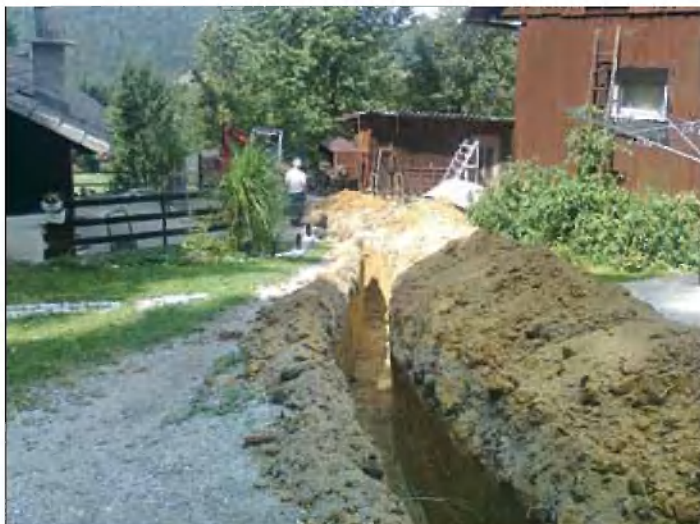
Obnova vodovoda Hrustovo
