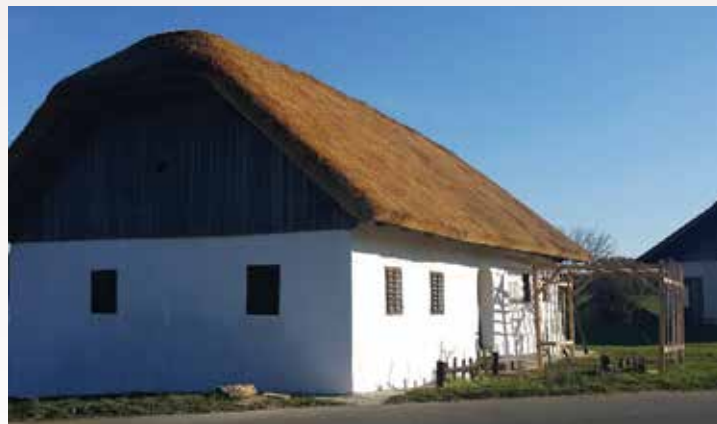
Jurjeva domačija predstavlja tipično arhitekturo lokalnega okolja iz začetka preteklega stoletja, za njeno obnovo pa smo pridobili tudi evropska sredstva.
