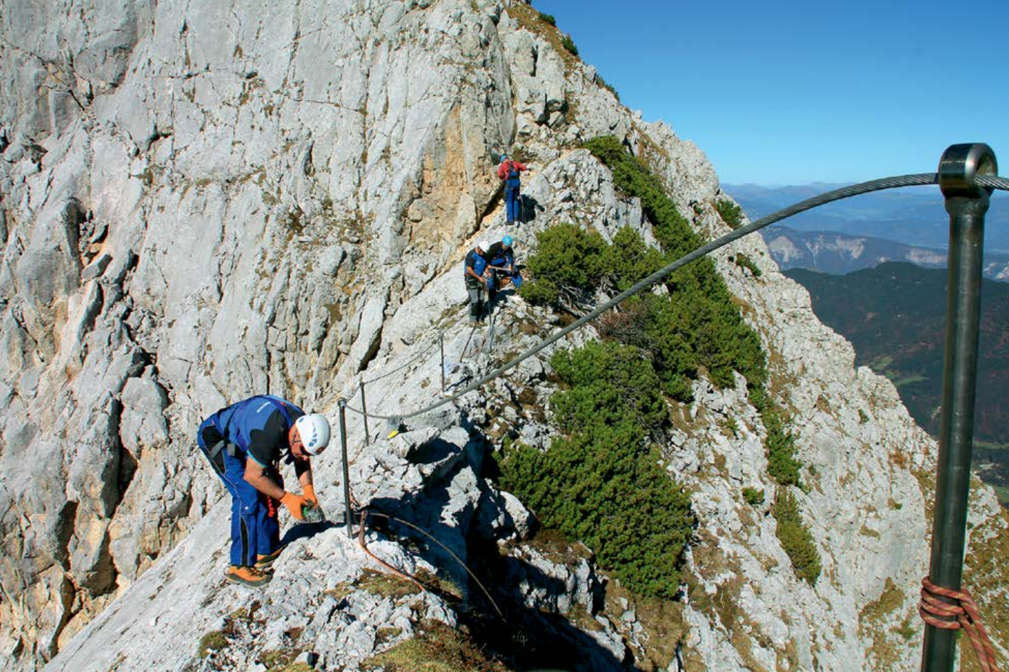
Jeklenica je napeljana, začenja se dokončanje del. Foto: Zdenka Mihelič
