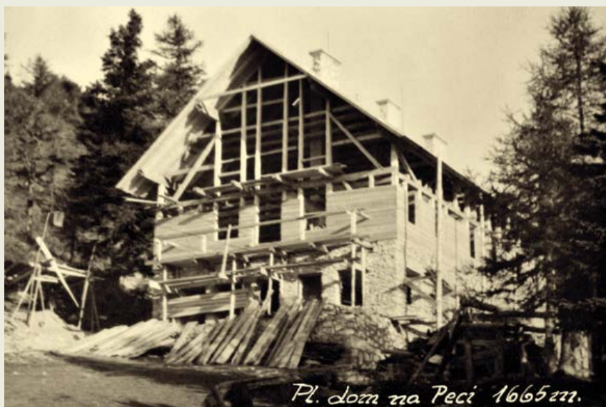
Dom na Peci v fazi gradnje leta 1957 Arhiv PD Mežica
