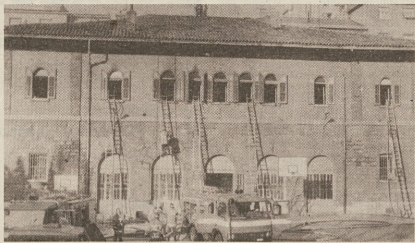
Gasilci so z brizgalkami po lestvah navalili v urade desnega trakta opustošenega poslopja. Uničena je bila tudi spodnja telovadnica
