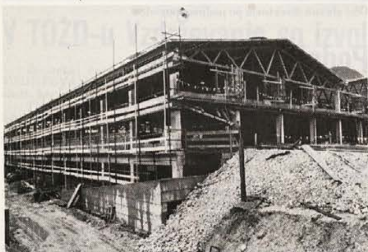
Novogradnja proizvodne hale smučí napreduje
