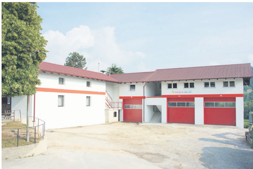
Gasilski dom v Prožinski vasi. V preteklih dneh je bila končana gradnja velikega prizidka.
