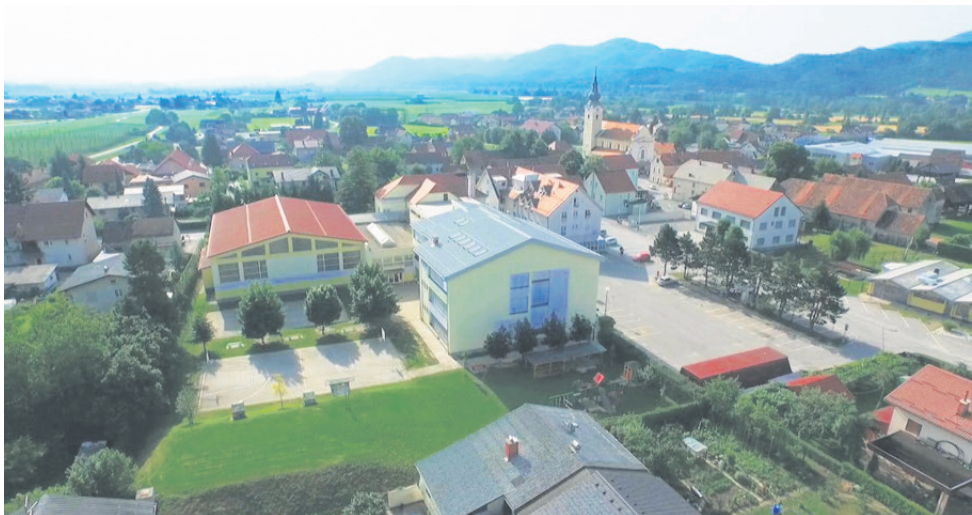
Najstarejši del zgradbe petrovške šole so zgradili pred več kot sto leti. Do zdaj so ji prizidali dva dela in telovadnico. Tokratna razširitev bo že četrta. (Foto: Prometna kača)
