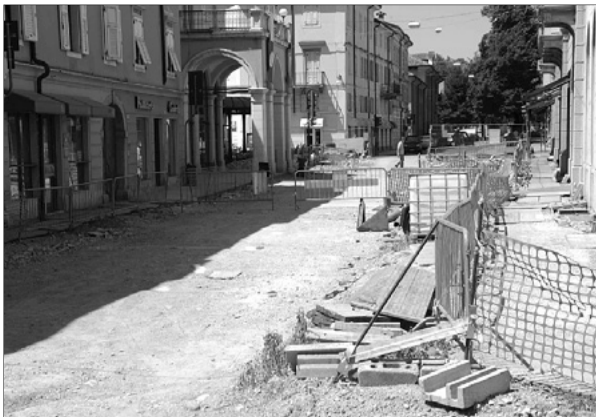
Gradbišče v ulici Garibaldi
