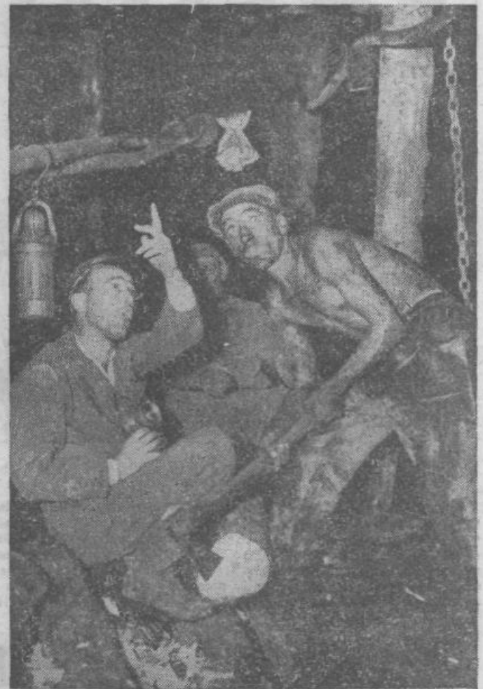
Postavljanje lesenih podpornikov v premogovniku »Kakanj«
