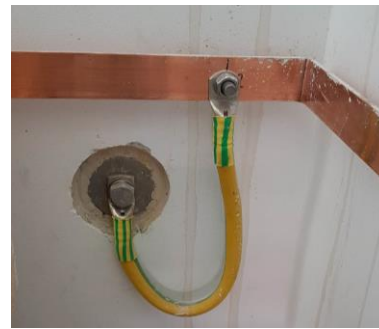
Slika 4. Povezava obroča izenačitve potencialov na armaturo
