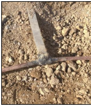
Slika 2. Spoj Rf trak - bakrena vrv
