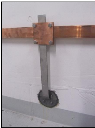
Slika 3. Spoj Rf trak - bakreni trak
