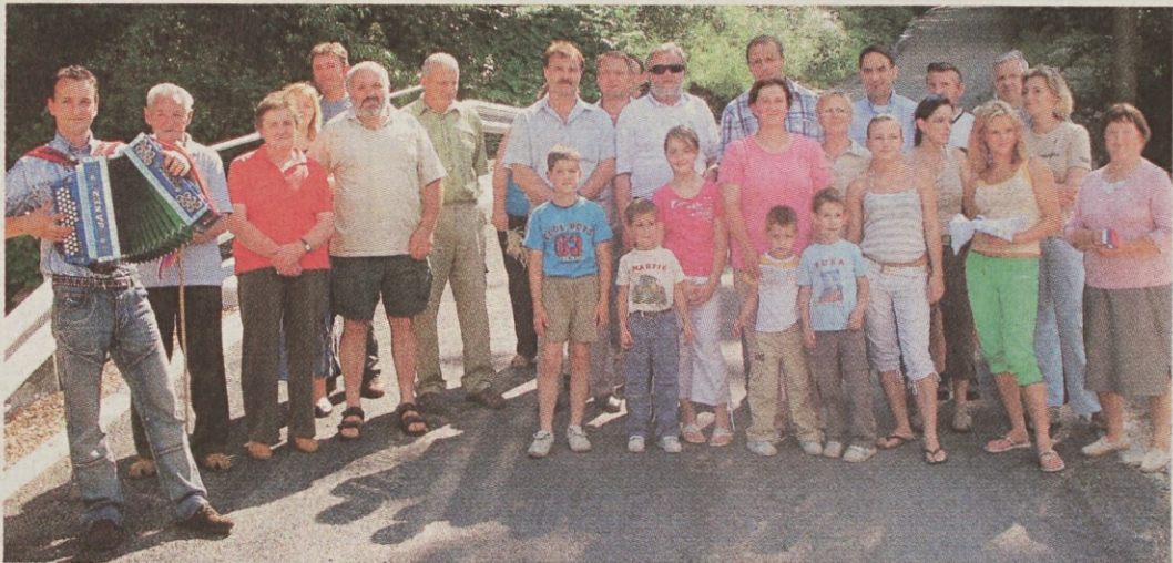
Vaščani Stebljevka so se s predstavniki Občine Kamnik in gosti veselili novega mostu preko potoka Tuhinjščica, ki jih povezuje z glavno cesto v Tuhinjski dolini.
