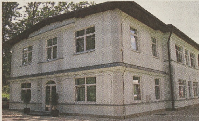
Znotraj območja KIK-a na Fužinah v Kamniku domuje tudi poslovna stavba družbe Kamnik - Schlenk, ki je bila že pred leti temeljito obnovljena. V njej so tudi sodobni prostori laboratorija.
