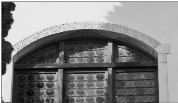
Slika 3: Lok nad tretjim baročnim oknom v južni fasadi, sestavljen iz treh monolitnih blokov nekdanjega gotskega arhivolta (foto: Jure Vuga).
