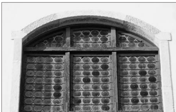
Slika 1: Lok nad prvim baročnim oknom v južni fasadi, sestavljen iz treh monolitnih blokov (sredinski kamniti blok je verjetno dopolnitev iz 18. stoletja) (foto: Jure Vuga).
