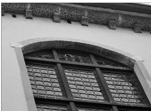
Slika 4: Lok nad tretjim baročnim oknom v severni fasadi (nad krstilnico), sestavljen iz štirih monolitnih blokov (foto: Jure Vuga).
