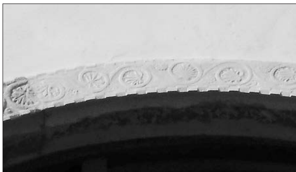
Slika 2: Povečava sredinskega dela loka nad prvim baročnim oknom v južni fasadi, ki je bil verjetno izdelan v 18. stoletju in oblikovan po vzoru originalnih gotskih kosov (foto: Jure Vuga).
