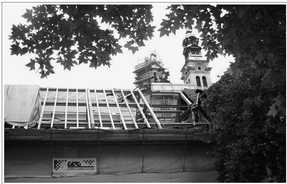
Obnova strešne konstrukcije uršulinskega samostana, pod katero so prostori Slovenskega šolskega muzeja, poletje 2005. (SŠM, fototeka)
