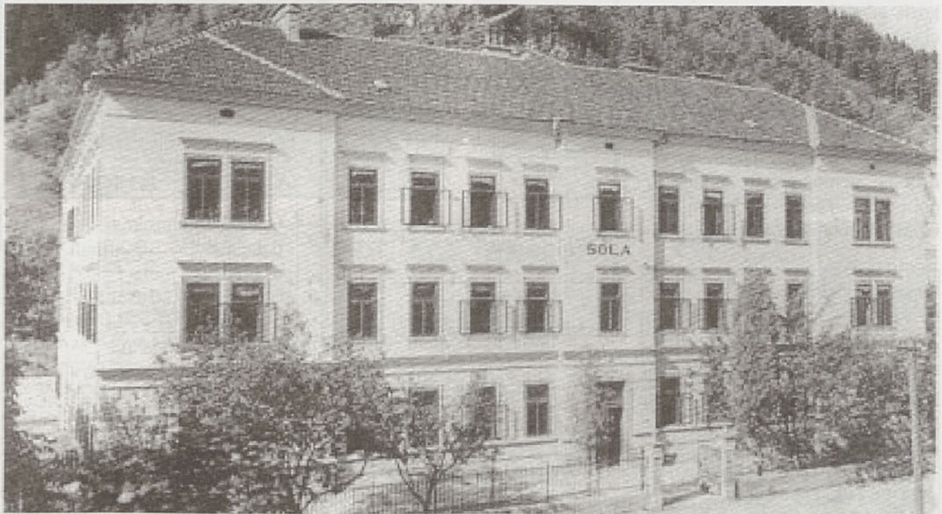
Šola v zgornjih Trbovljah, zgrajena leta 1901 (Vir: Lebar, I.I., 1992)
