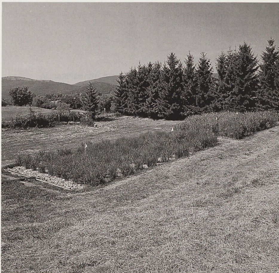
Pogled na delujočo rastlinsko čistilno napravo za gospodinjske odplake vasi Ponikva, Šentjur pri Celju, po idejno-tehnološkem projektu podjetja LIMNOS, d.o.o., Ljubljana
