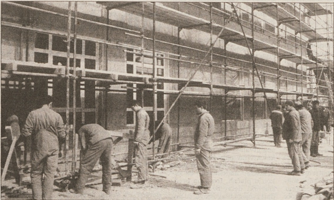
Filc Mengeš: Nova proizvodna stavba, v kateri bodo izdelovali nov izdelek in podvojili vrednost proizvodnje. Stavbo še dokončujejo, notri pa že nameščajo stroje. Proizvodnja bo stekla konec maja letos.
