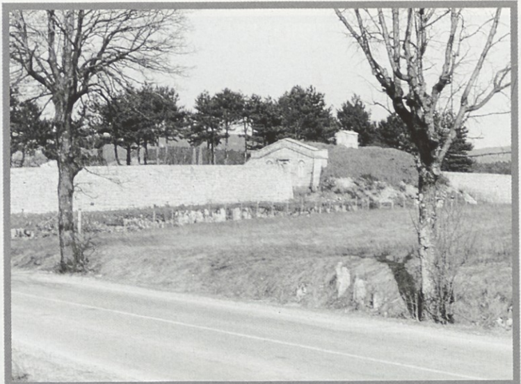
Vodni rezervoar v Divači je spomeniško zaščiten.
