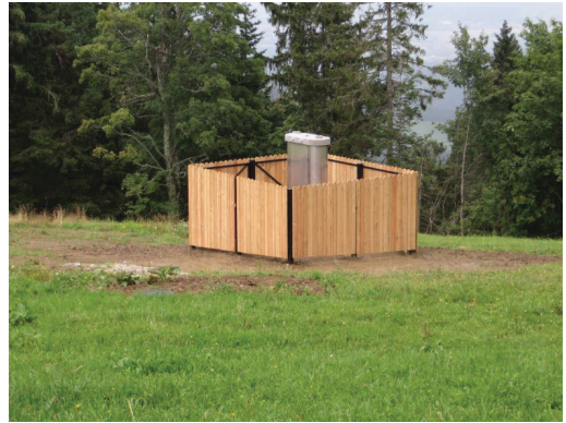
Slika 16: Gradnja točke kombinirane geodetske mreže na Arehu (levo vir: TERRAS, s. p., desno vir: GURS).
