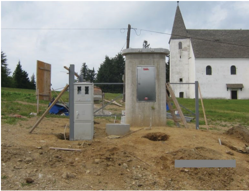
Slika 16: Gradnja točke kombinirane geodetske mreže na Arehu (levo vir: TERRAS, s. p., desno vir: GURS).
