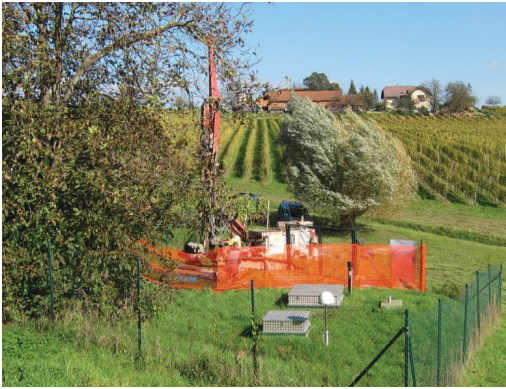
Slika 13: Gradnja točke kombinirane geodetske mreže na Kogu (levo vir: TERRAS, s. p., desno vir: GURS).
