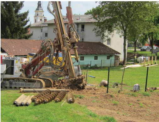
Slika 14: Gradnja točke kombinirane geodetske mreže v Šentvidu pri Stični (levo vir: TERRAS, s. p., desno vir: GURS).
