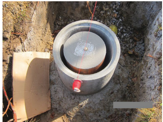
Slika 11: Načrt točke zavarovalne mreže (PZI) (levo, vir: Popović et al., 2013) in točka zavarovalne mreže v gradnji v Prilozju (desno, vir: GURS).
