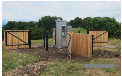
Slika 15: Gradnja točke kombinirane geodetske mreže na Koradi (levo vir: TERRAS, s. p., desno vir: GURS).
