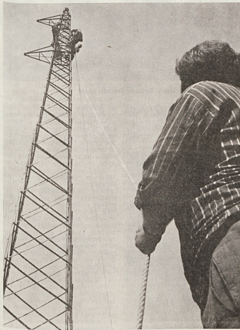
Gradnja novega električnega 110 KV daljnovoda od Logatca do Loškega poija, ki naj bi se končala z razdelilno transformatorsko postajo. Pot daljnovoda se bo nadaljevala v Loško dolino.
