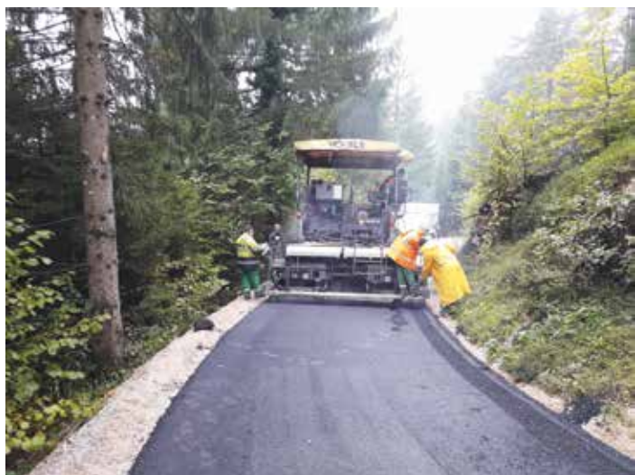
Asfaltiranje odseka Podhojni Hrib–Laze
