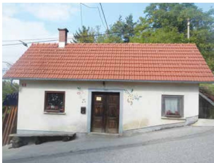
Sušilnica z novo streho in dimnikom
