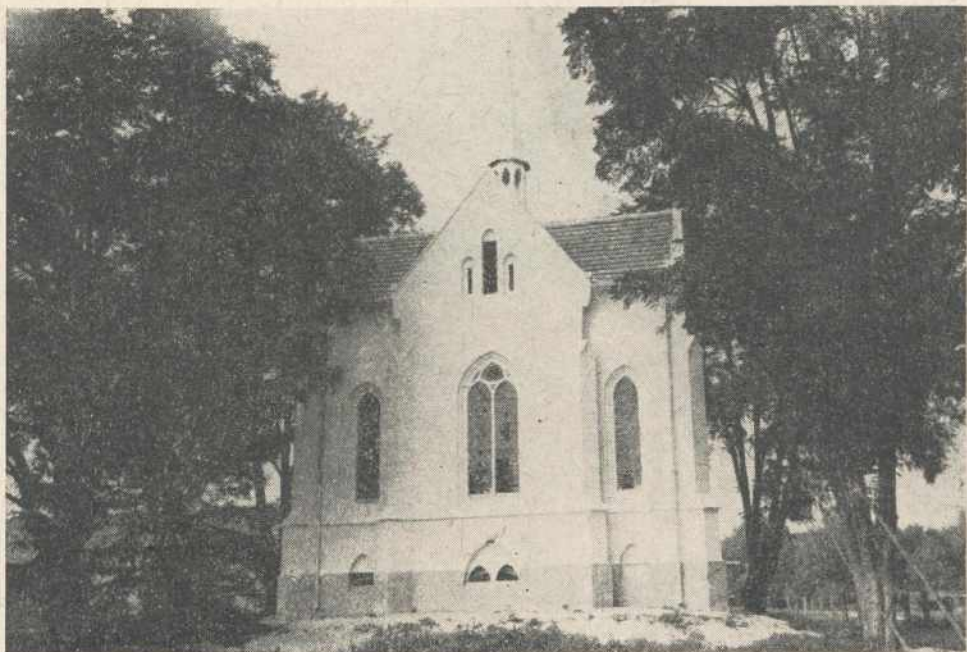
Obnovljena kapela na Petanjcih
