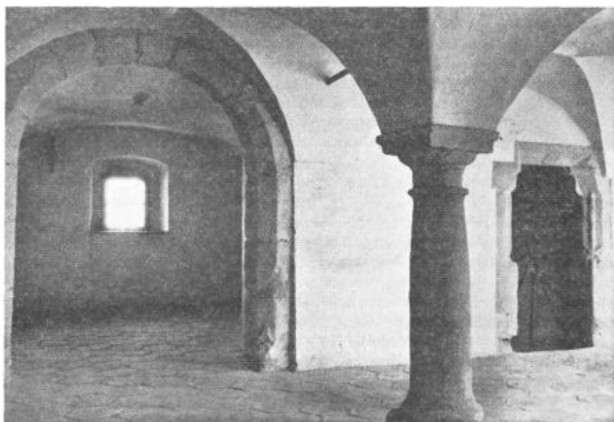
Sl. 8. — Pogled z dvorišča v vhodno vežo pred odstranitvijo lažnega oboka — foto V. B.
