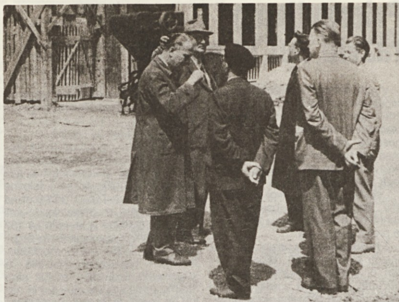
Franco Leskošek na gradbišču tovarne avtoopreme.
