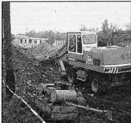
Izkop za kanalizacijo so pričeli pri Glinu (foto: F. Kotnik)
