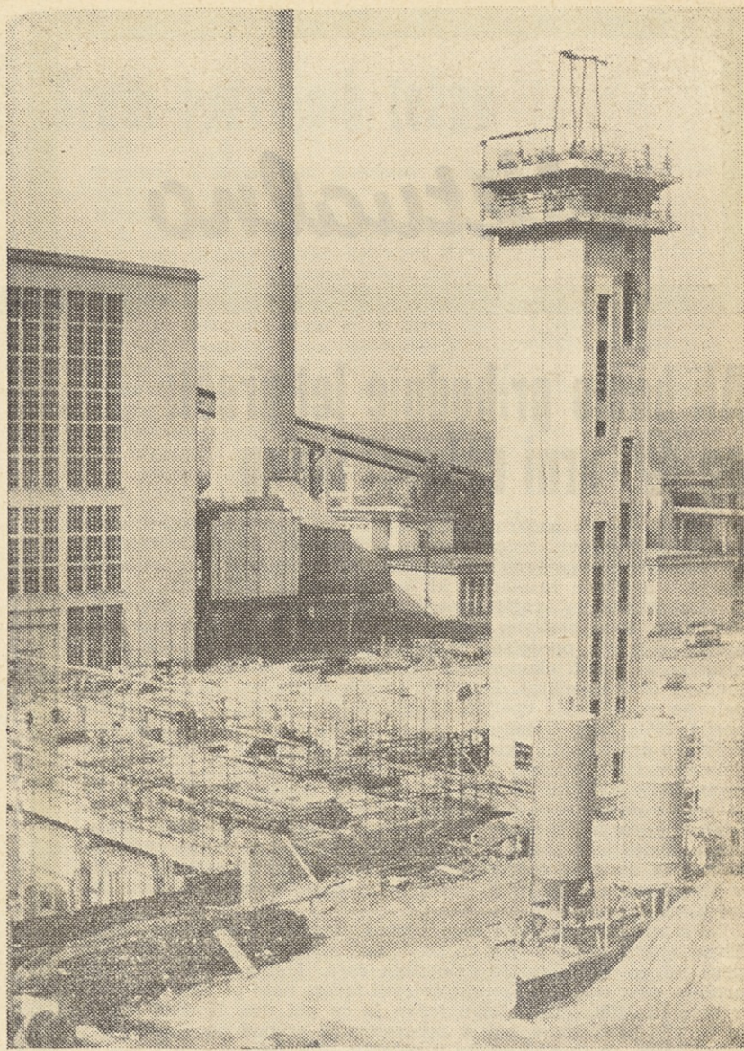
Delo na termoelektrarni v Šoštanju izredno hitro napreduje. Pogled na sodobno urejeno gradbišče
