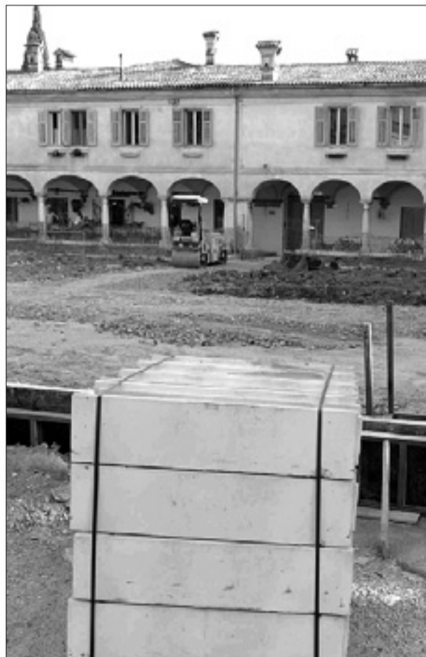
Gradbišče na trgu Sv. Antona
