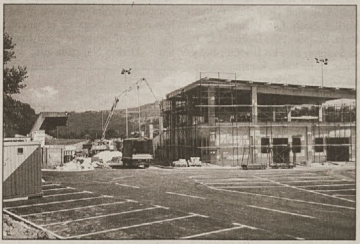
Gradnja novega objekta poteka nemoteno, kmalu pa se obeta tudi posodobitev tribune in izgradnja novih.
