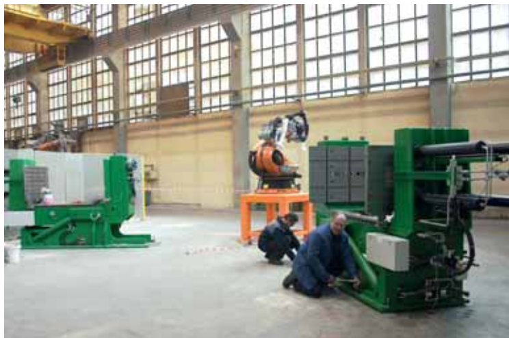
Montaža livne celice v Talum Ulitki
