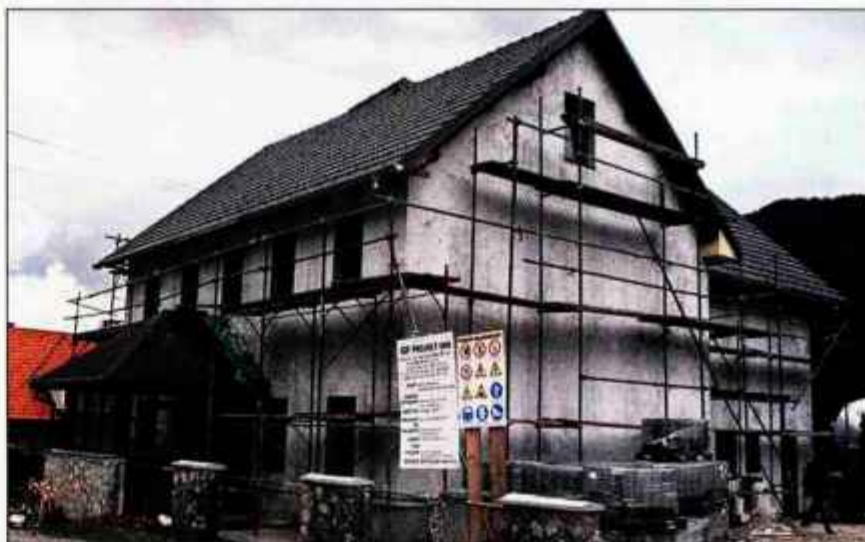
V drugi polovici septembra so izdelovali fasado na prizidku in stari stavbi.
