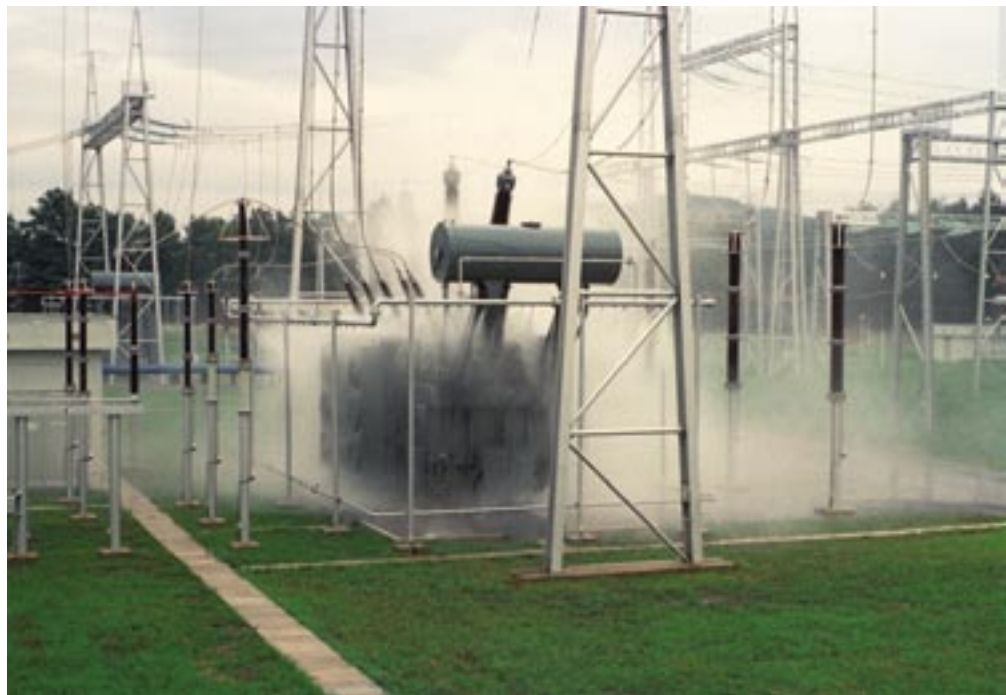
Preizkus delovanja protipožarne gasilne naprave na transformatorju TR 42 (1976).
