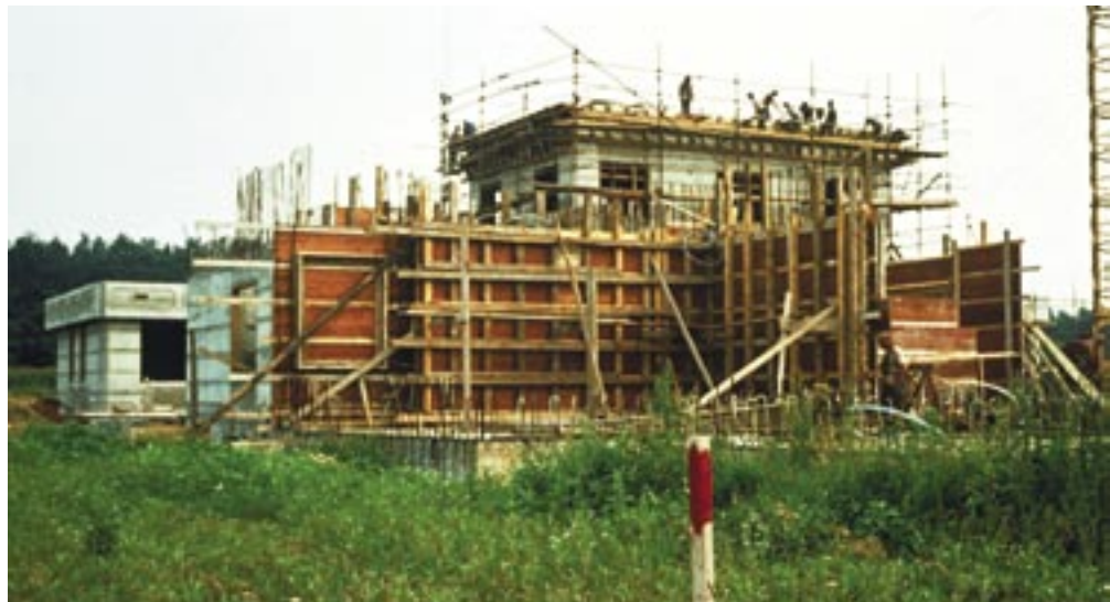
Komandna zgradba (spredaj) in montažni stolp (zadaj) med gradnjo (1975).
