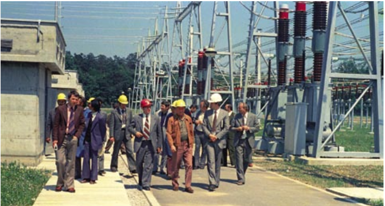
Komisija za tehnični pregled objekta pred rednim obratovanjem (1978).
