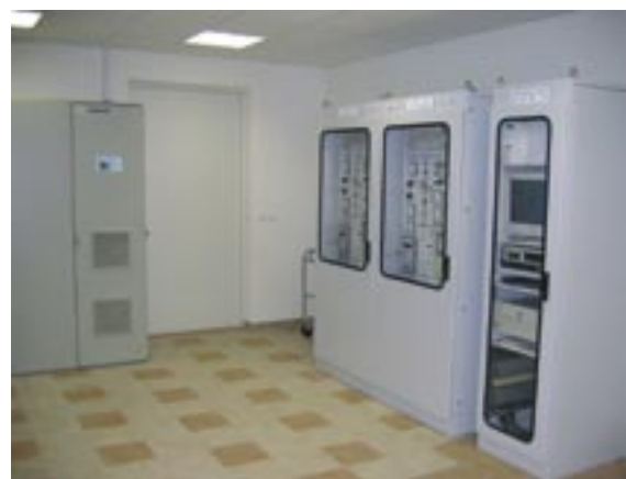
Slika 2: Nov komandni prostor omare vodenja in zaščite za TR I in II.
