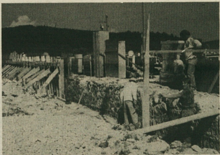
OBNAVLJAJO OGRAJO OKOLI POKOPALIŠČA - Na Vidmu v občini Dobrepolje obnavljajo ograjo pokopališča, ki je popolnoma dotrajana, saj se je že podirala. Z obnovitvenimi deli so začeli že lani. Letos bodo dokončali nadaljnjih 100 m ograje, kar bo veljalo 2,5 milijona tolarjev, v naslednjih letih pa je bo potrebno obnoviti še okoli 250 m. Dela izvaja podjetje Kogra iz Klinje vasi pri Kočevju. (Foto: J. Primec)
